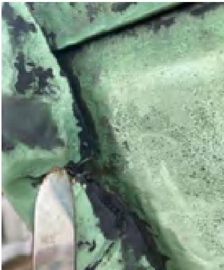
Über die komplette Zwiebelverkleidung verteilt sind zahlreiche Spannungsrisse sowie Risse und defekte Stellen an den Falzen ersichtlich. © Spenglerei Winter
